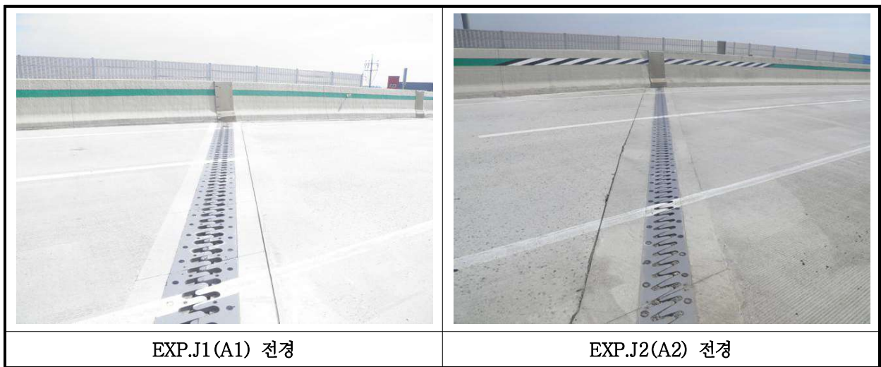
【사진 32.3.16】 신축이음장치 전경
