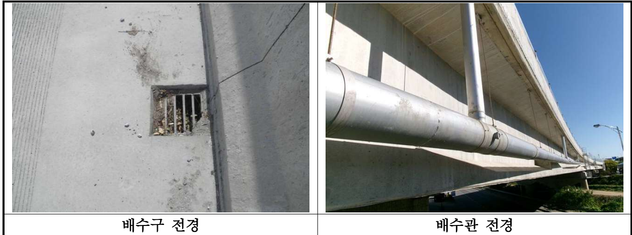
【사진 32.3.21】 배수시설 전경
