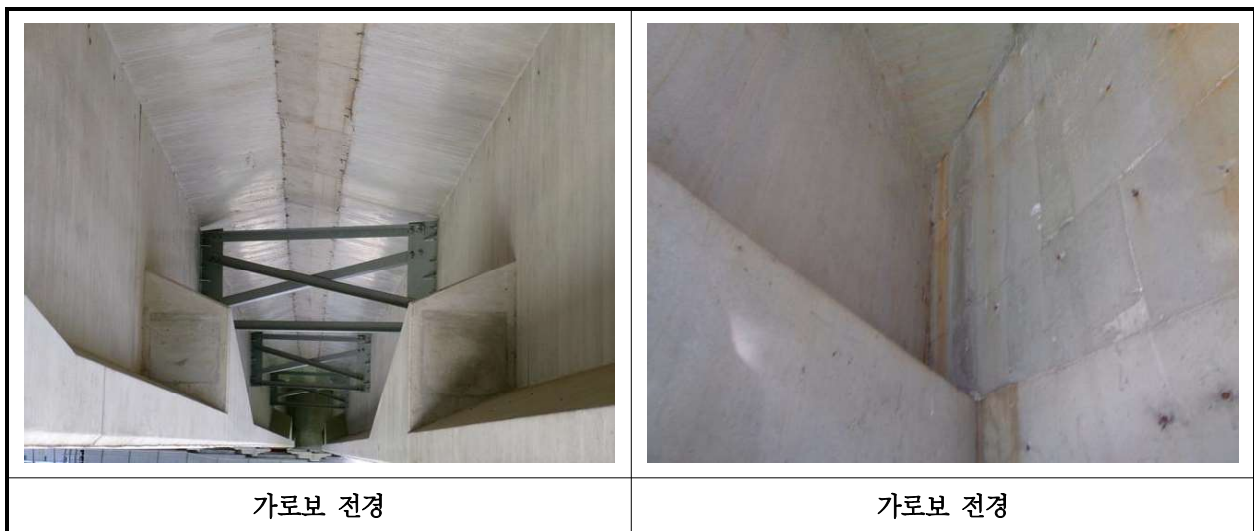
【사진 31.3.6】 가로보 전경
