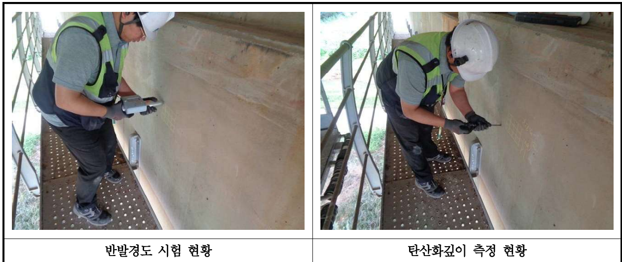
【사진 31.4.1】 콘크리트 내구성조사 현황
