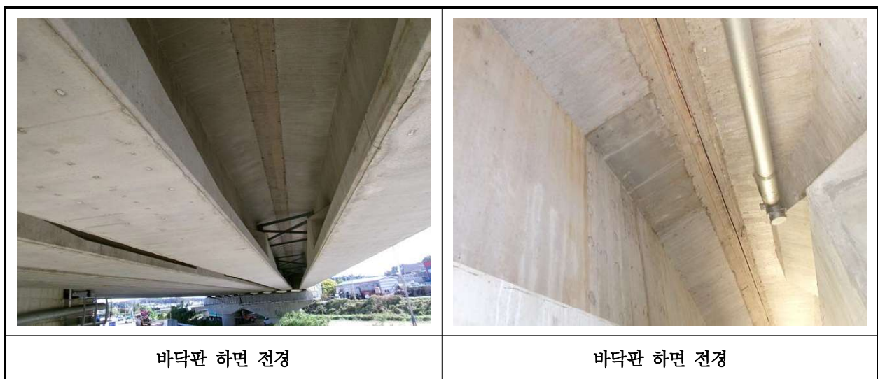
【사진 31.3.2】 바닥판하면 전경
