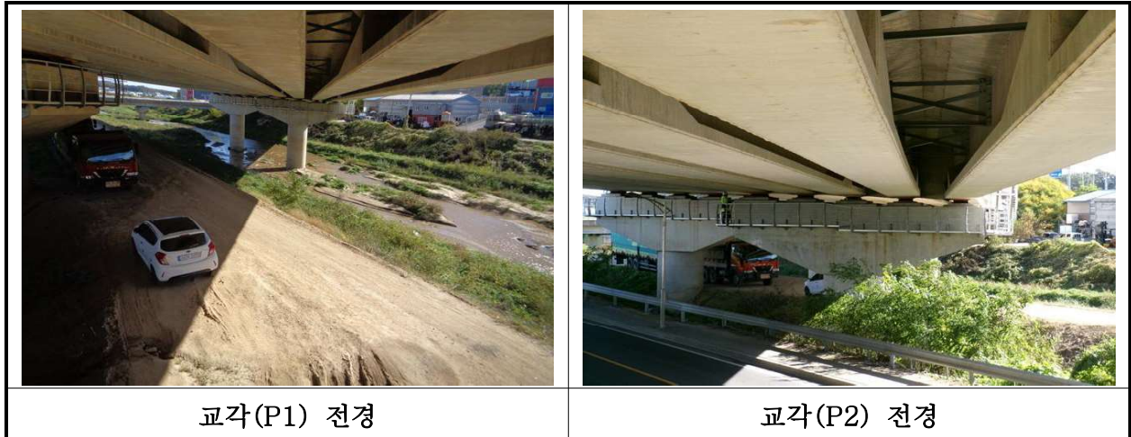
【사진 31.3.10】 교각 전경
