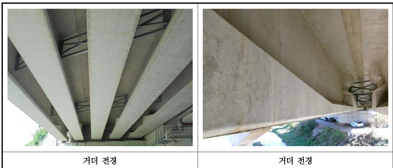
【사진 31.3.4】 거더 전경
