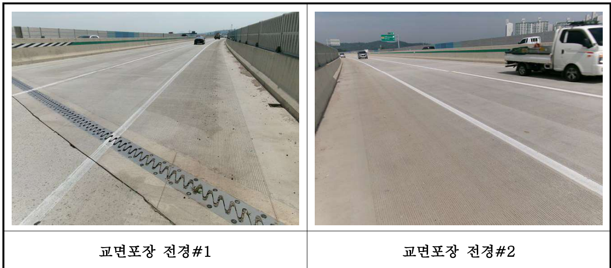
【사진 32.3.19】 교면포장 전경
