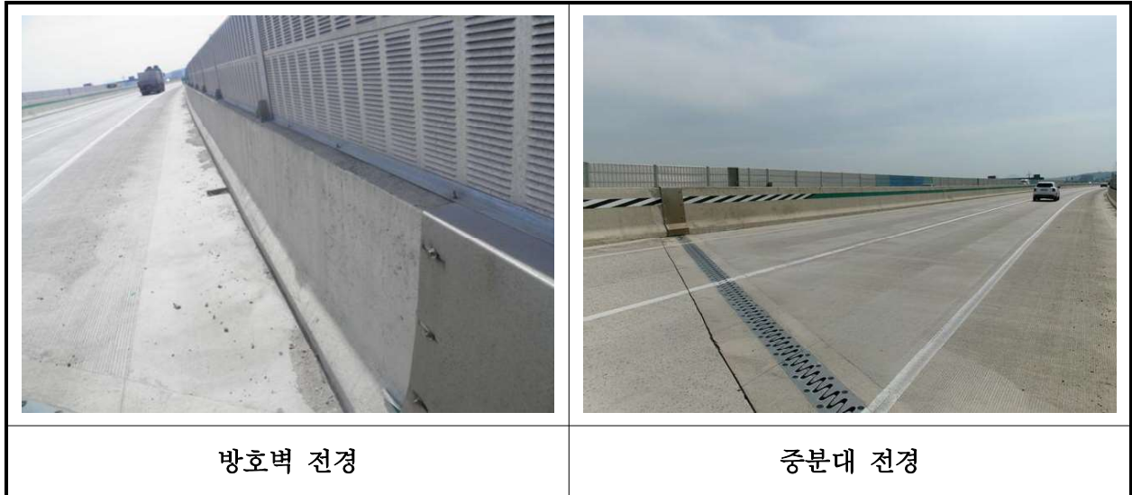
【사진 32.3.23】 방호벽 및 중앙분리대 전경
